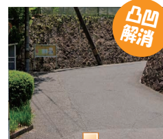
道路舗装修繕
