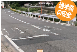
横断歩道補修
