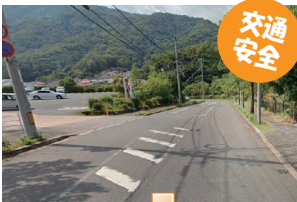
横断歩道新設
